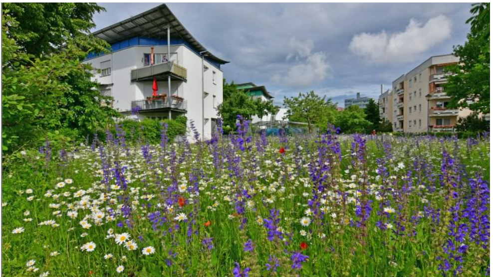
Was für ein tolles Wohnumfeld! Gemeinnützige Wohnungsbaugesellschaft Ingolstadt.
